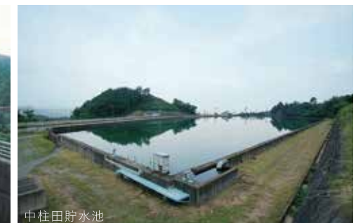
中柱田貯水池
