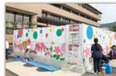
役場庁舎前の非常用自家発電フェンス
