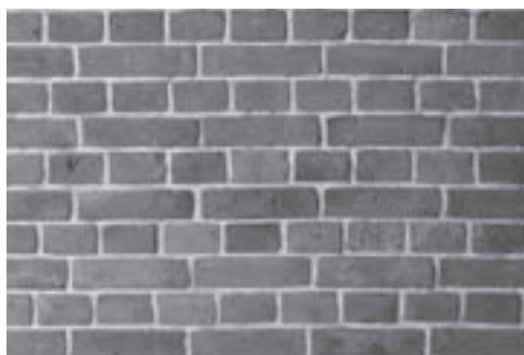
城山3：橋梁内部の煉瓦積み（筑紫野市）
