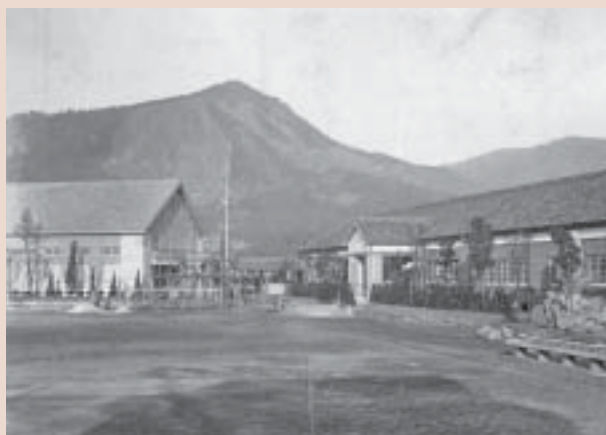
▲写真4 工事中の奉安殿
