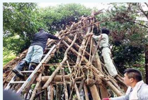
竪穴式住居解体
