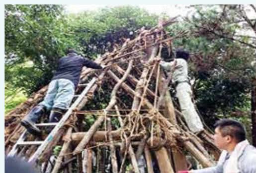
竪穴式住居解体
