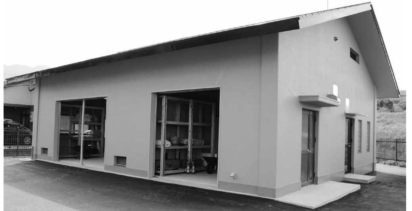
東部防災センターの外観
