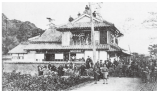
写真1 昔の県道(須恵橋から一番田へ抜ける道)石炭運搬用のトロッコ軌道が見える
