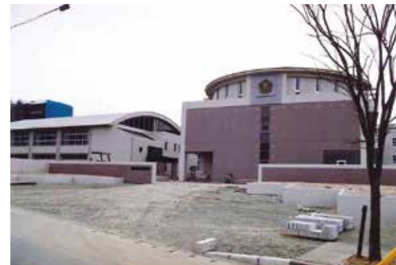
開校に向けて工事中の須恵第三小学校
