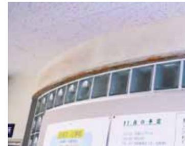
内部鉄部の腐食
