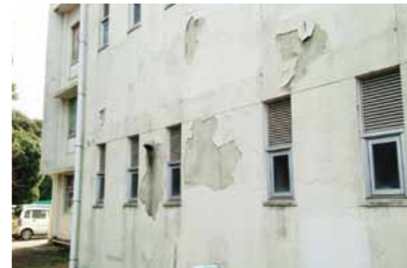
校舍北面塗装の剥離
