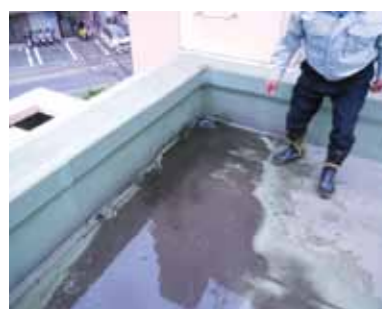
ドレンの詰まり
