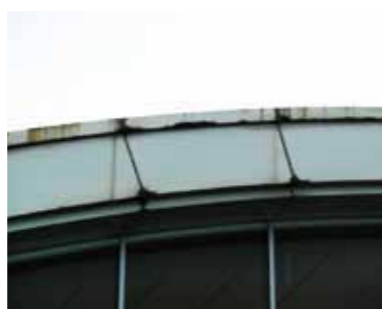
体育館外部鉄部の錆
