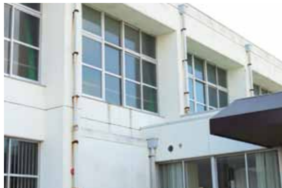
外壁塗装の劣化
