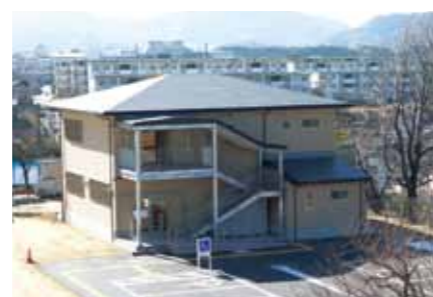
第一学童保育所建築工事
