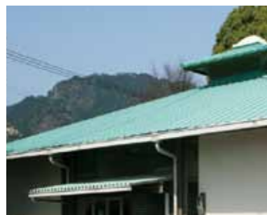
平成19年に改修された屋根
