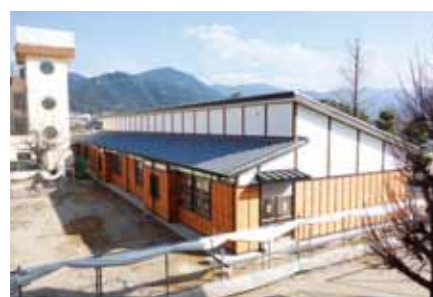
第二小校舎増築工事
