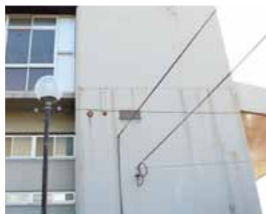
外壁塗装の劣化
