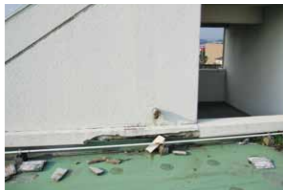
屋上外壁の破損
