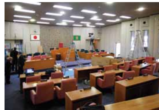
改修工事中の古賀市議会議場
