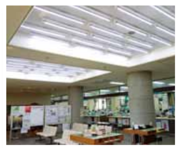
LED照明に取り替えられた役場庁舎
