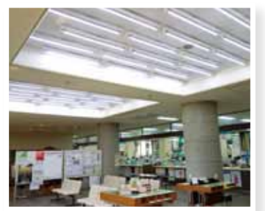
LED照明に取り替えられた役場庁舎
