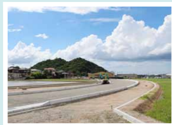
開通に向け工事が進む志免須恵線
