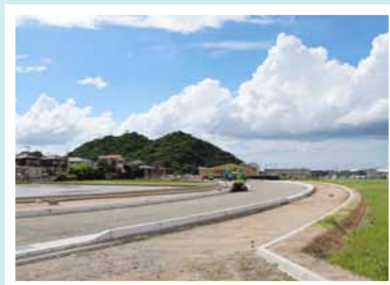
開通に向け工事が進む志免須恵線
