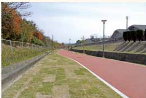
全線 幅員3mのゴムチップ舗装の歩道
