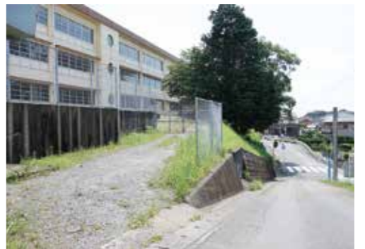
進入口が鋭角になっている校舎北側
