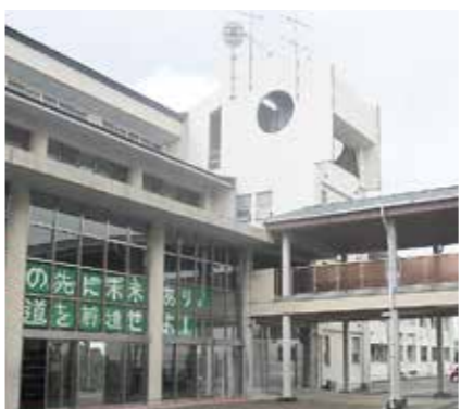
開校から27年が経過した校舎
