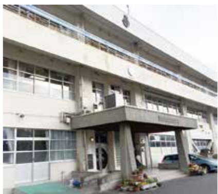
老朽化が目立つ正面玄関外壁
