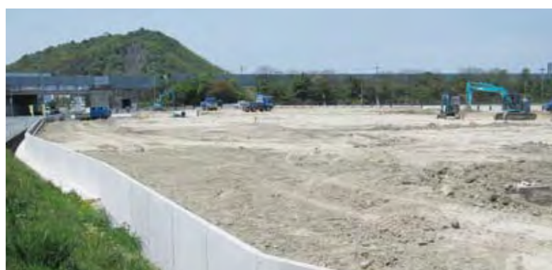
工事が進む第二幼児園
