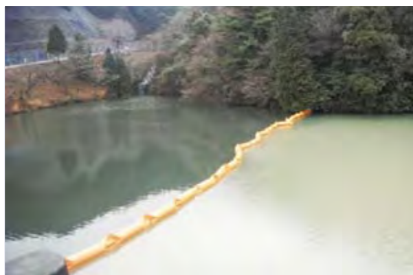
泥水防護膜が設置された須恵ダム
