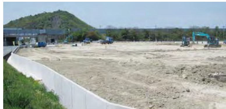
工事が進む第二幼児園
