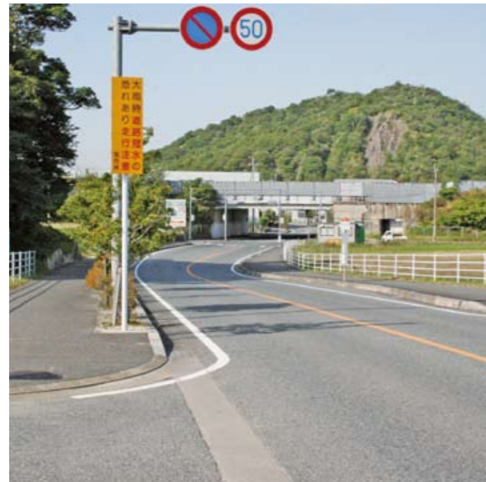
大雨時、道路冠水が心配される 旅石宮ノ下交差点
