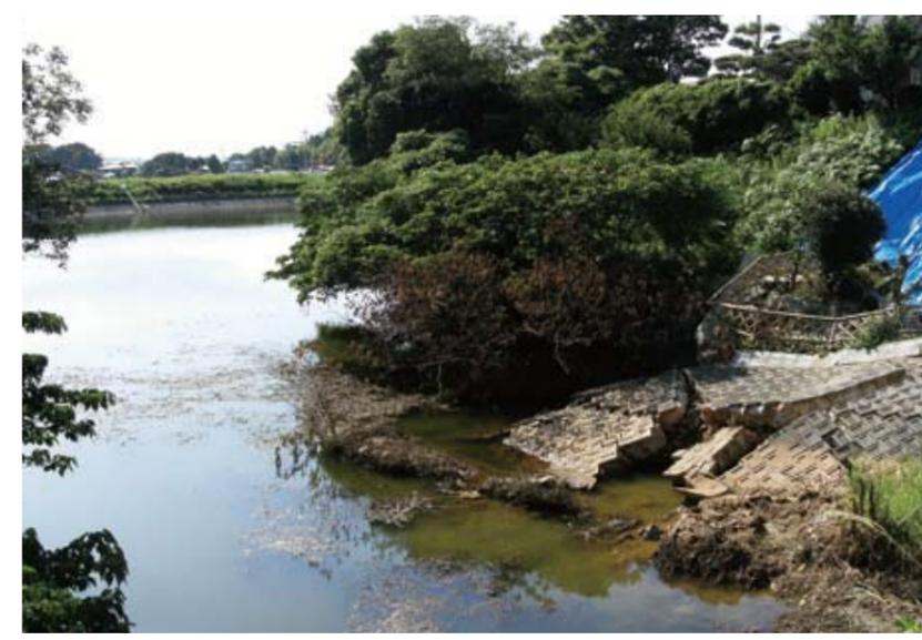
大雨により護岸が崩壊した脇田ため池(平成21年7月)
