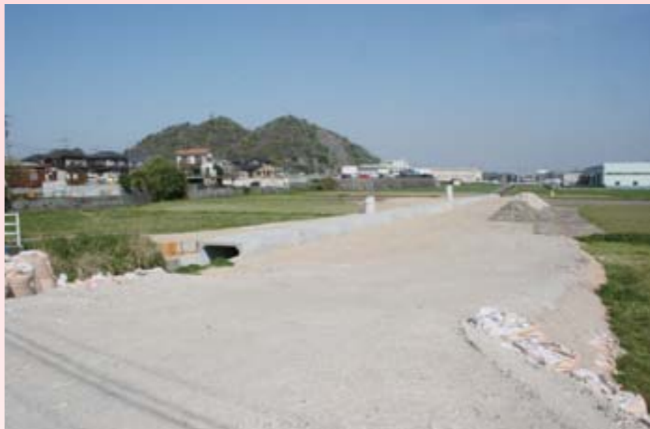
工事が進む「志免～須恵線」
