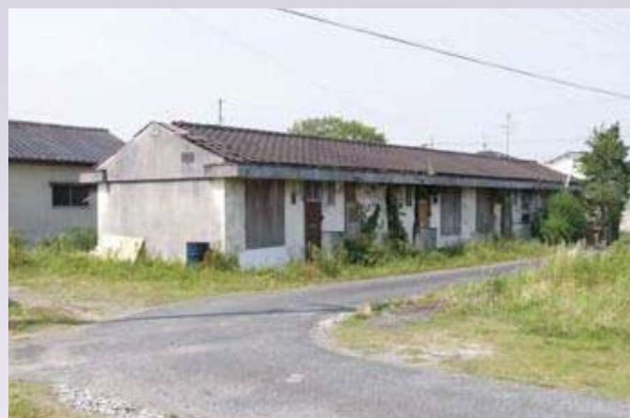
解体された「町営住宅」
