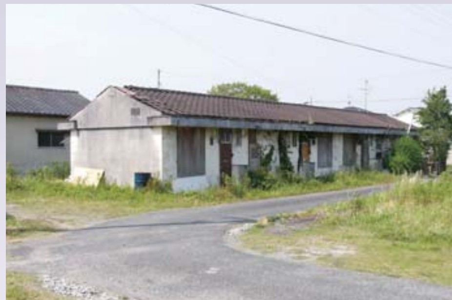
解体された「町営住宅」
