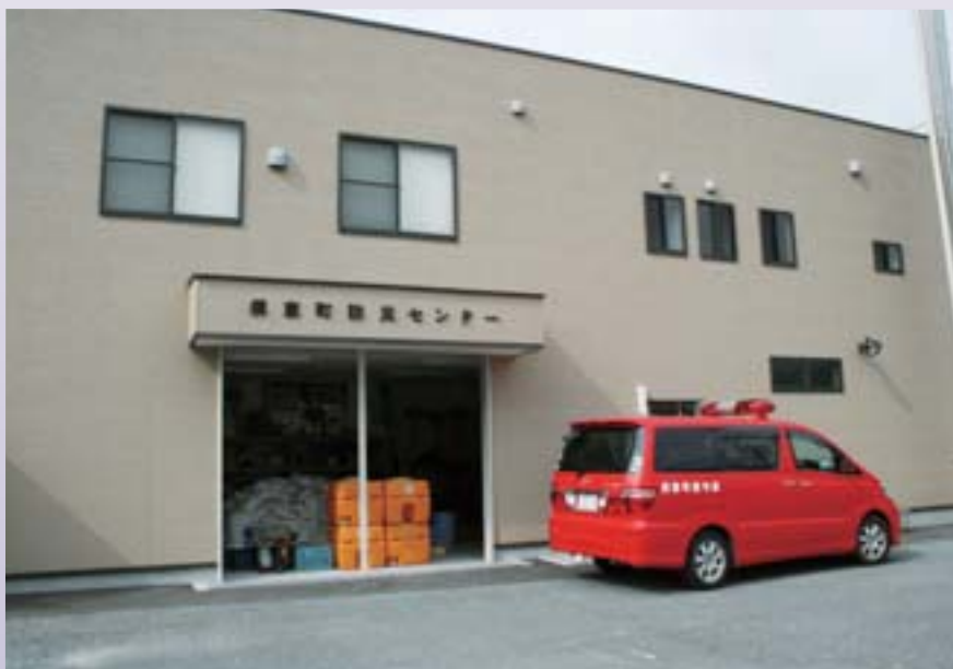
庁舎東側駐車場に建設された「防災センター」
