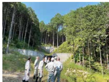
複数の治山ダム
