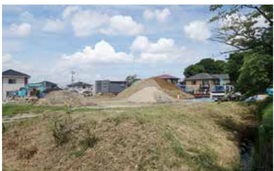
造成中の中部防災センター
