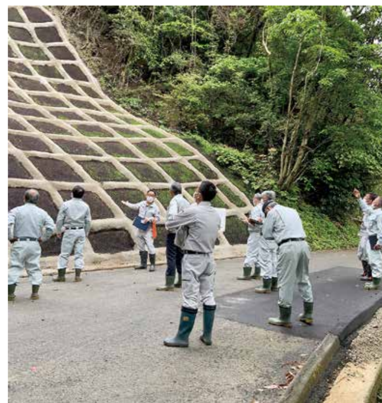
林道東原線2工区災害復旧工事
