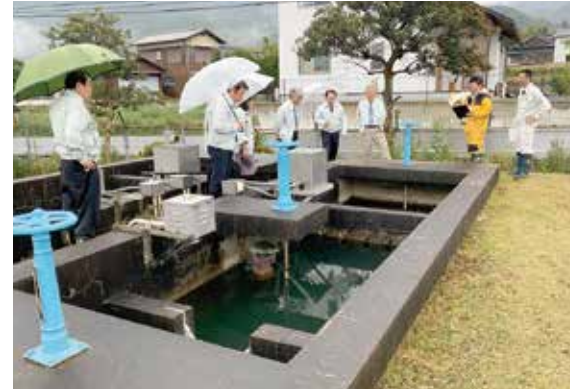
佐谷浄水場を視察
