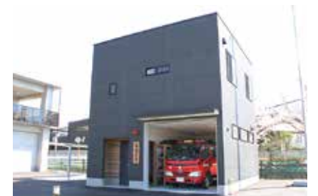
地域防災の要！須恵町消防団格納庫
