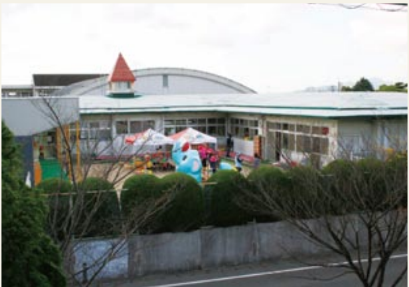
屋根の防水改修工事が行われるアザレア幼児園(にこにこルーム)
