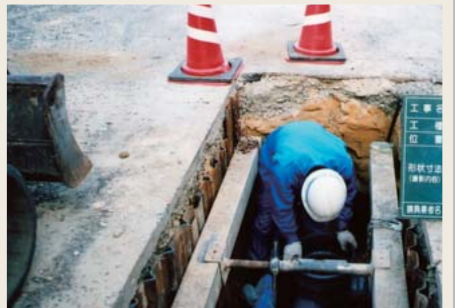
下水道工事の様子
