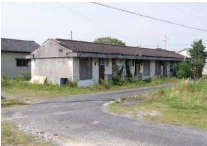
解体される「町営住宅」
