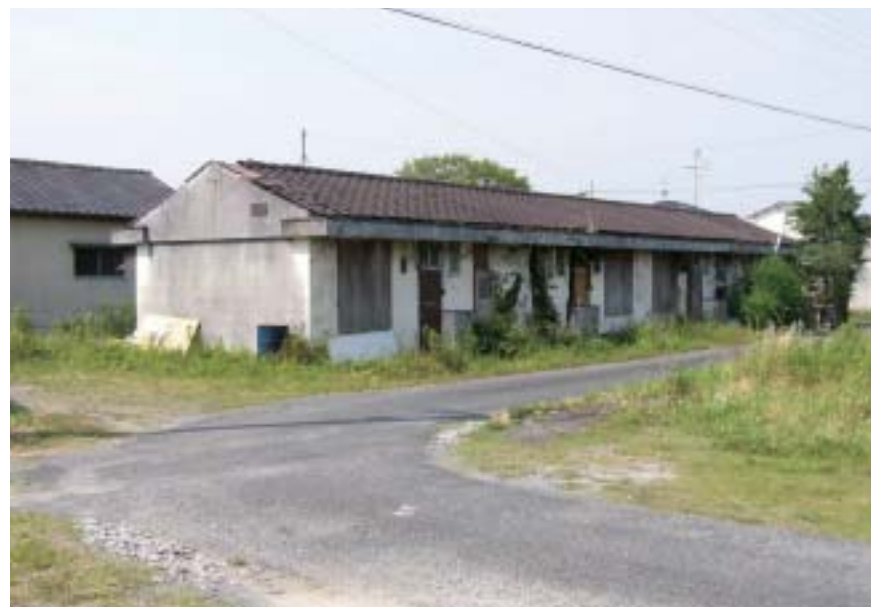
解体される「町営住宅」
