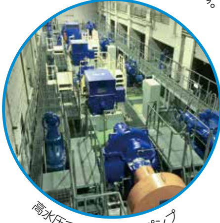
昭和60年から生活を支え続ける可動堰
