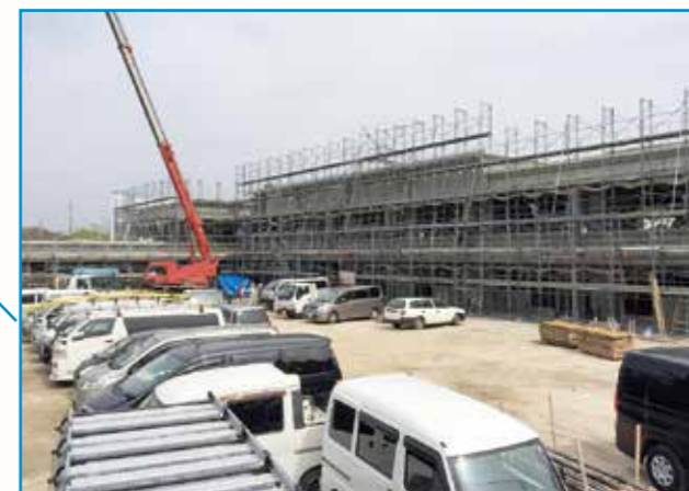
着々と進む工事(旧山の神グラウンド)
