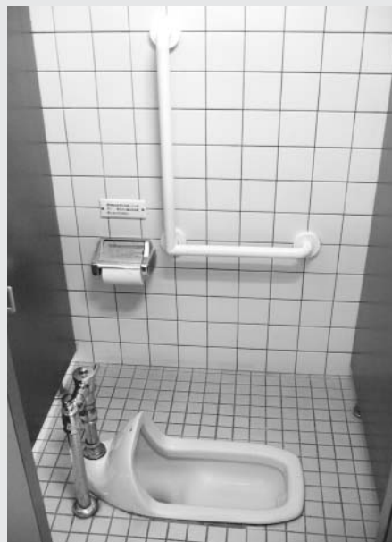
手すりが取り付けられた庁舎トイレ
