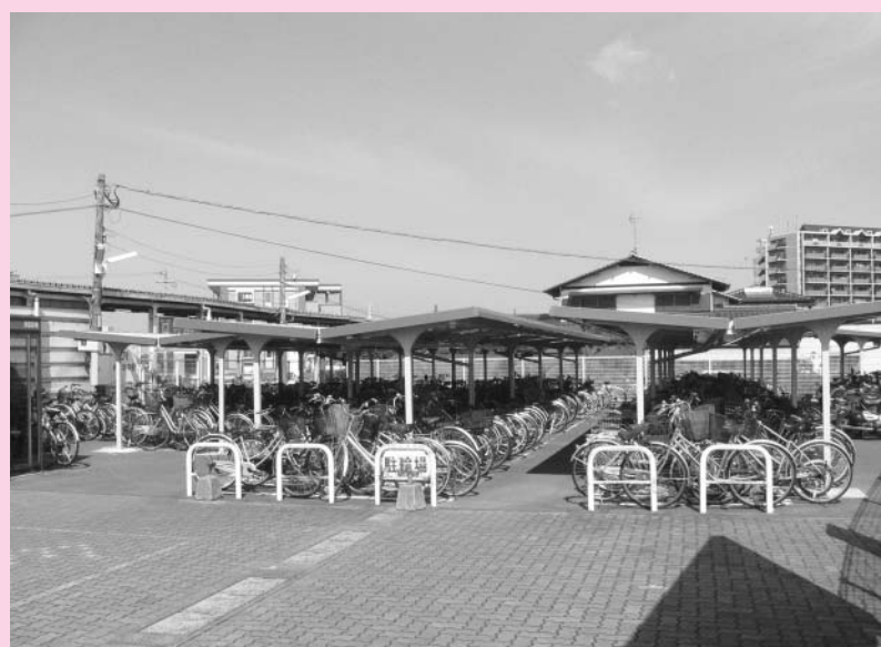
屋根が設置された須恵中央駅「駐輪場」
