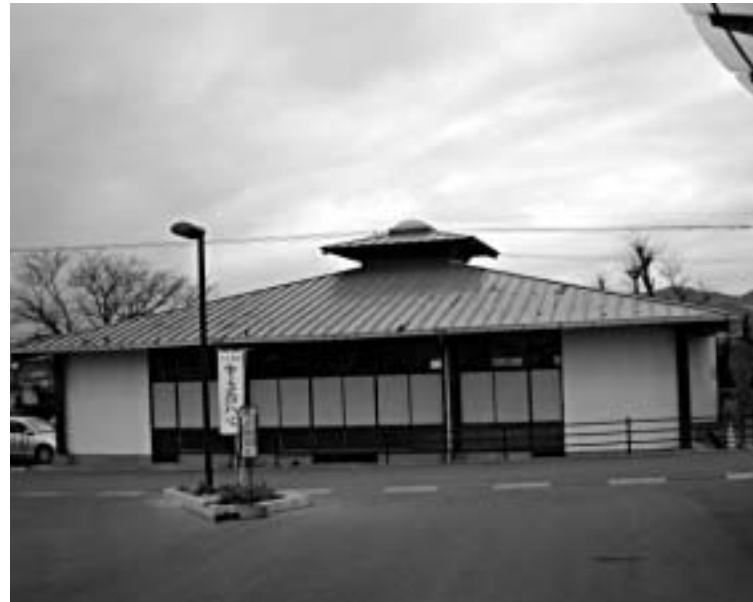
劣化が激しい町立武道場
