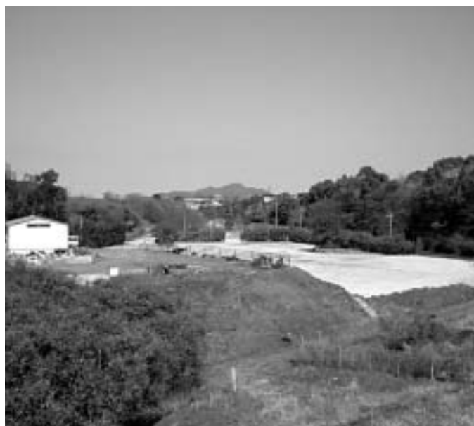
解体が行なわれた焼却場跡地
