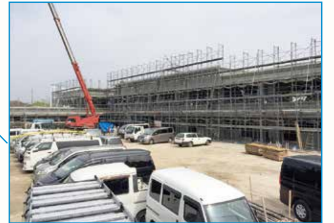
着々と進む工事(旧山の神グラウンド)
