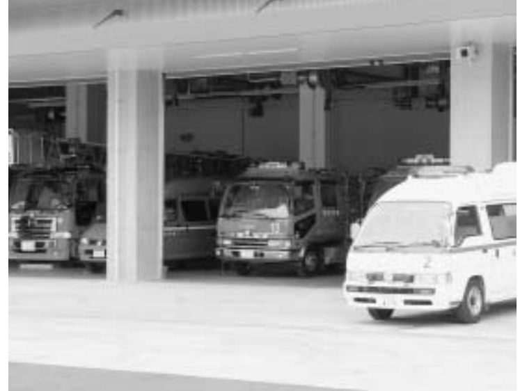
粕屋南部消防組合 “南部消防署”
