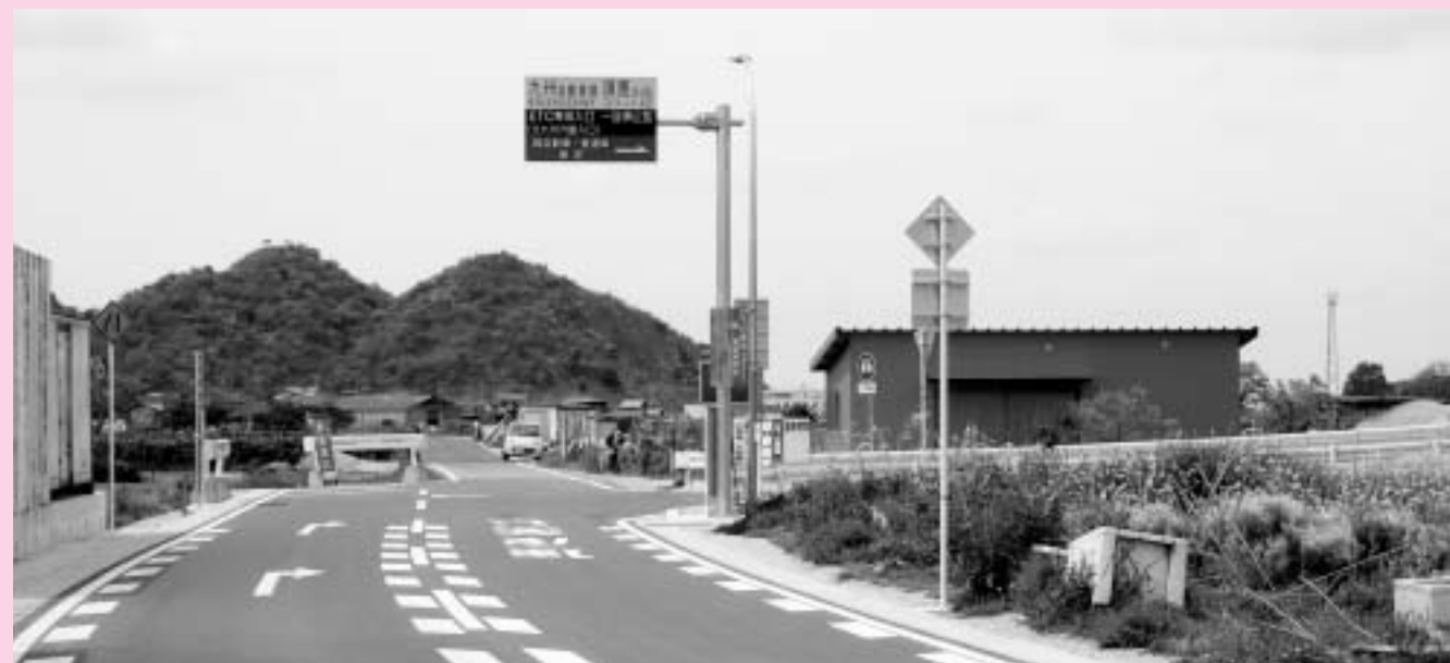
須恵スマートインターチェンジ上り出入口（赤坂地区）
