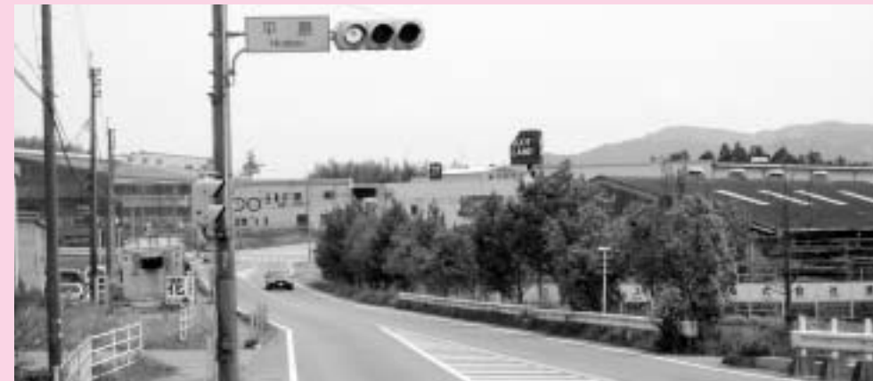
拡幅工事が計画されている筑紫野～古賀線
