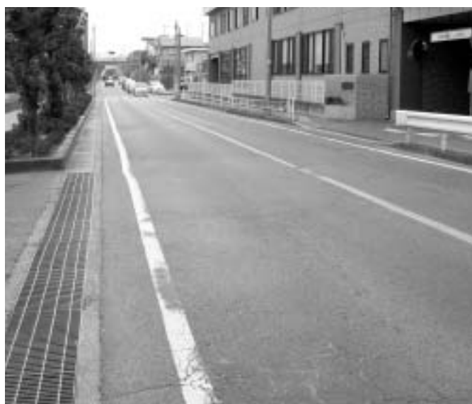
舗装改良工事が行われる町道須恵～井尻線(新生バス停前)
