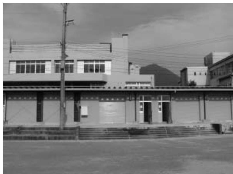
改修工事が行われた健康広場管理棟
