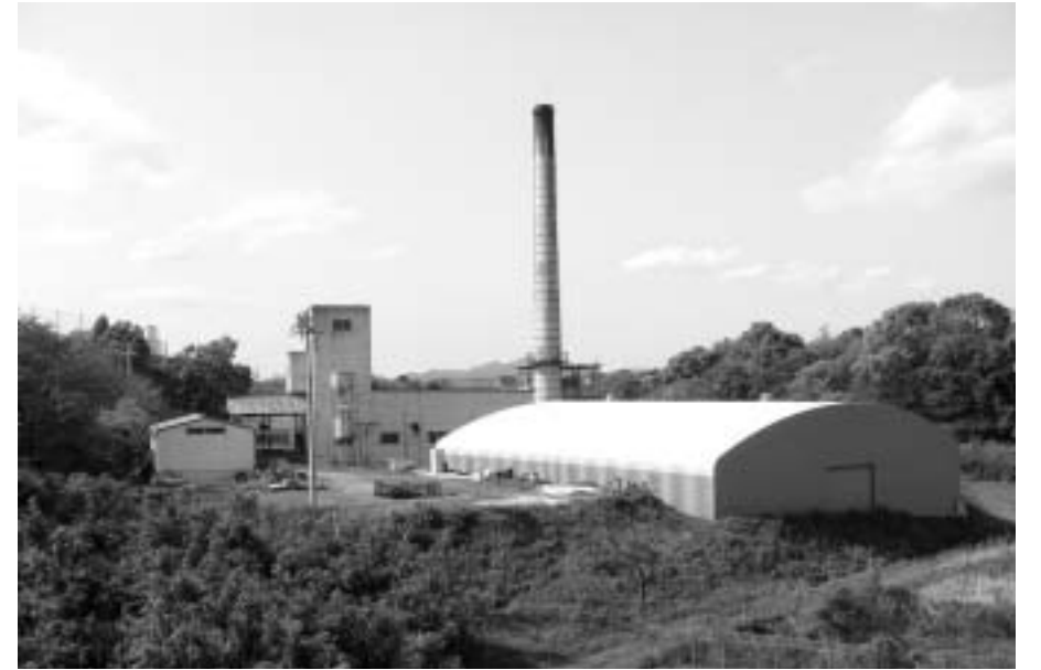
約25年間、もえるごみを処理してきた塵芥焼却場
