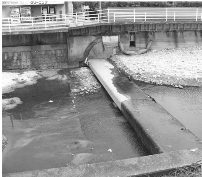
改修される新法尺堰
