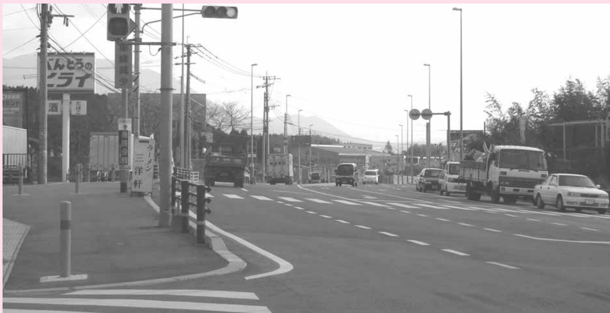
拡張工事が進む古賀～二日市線
