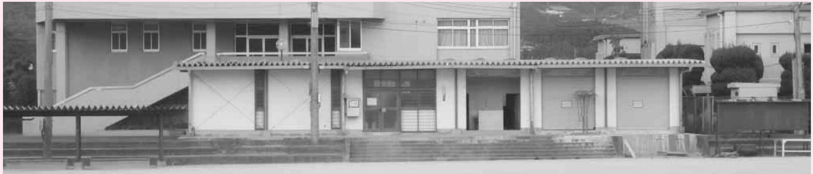
アスベストにより一部使用が禁止されている健康広場管理棟
