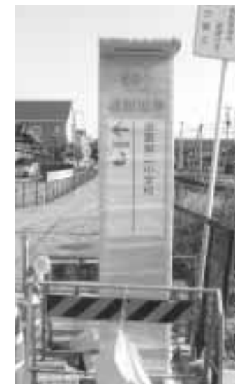
設置工事が進んでいる避難場所の標識
